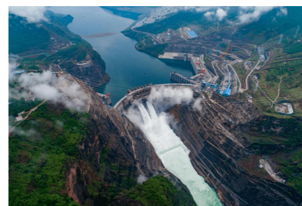
白鹤滩水电站特高压工程
