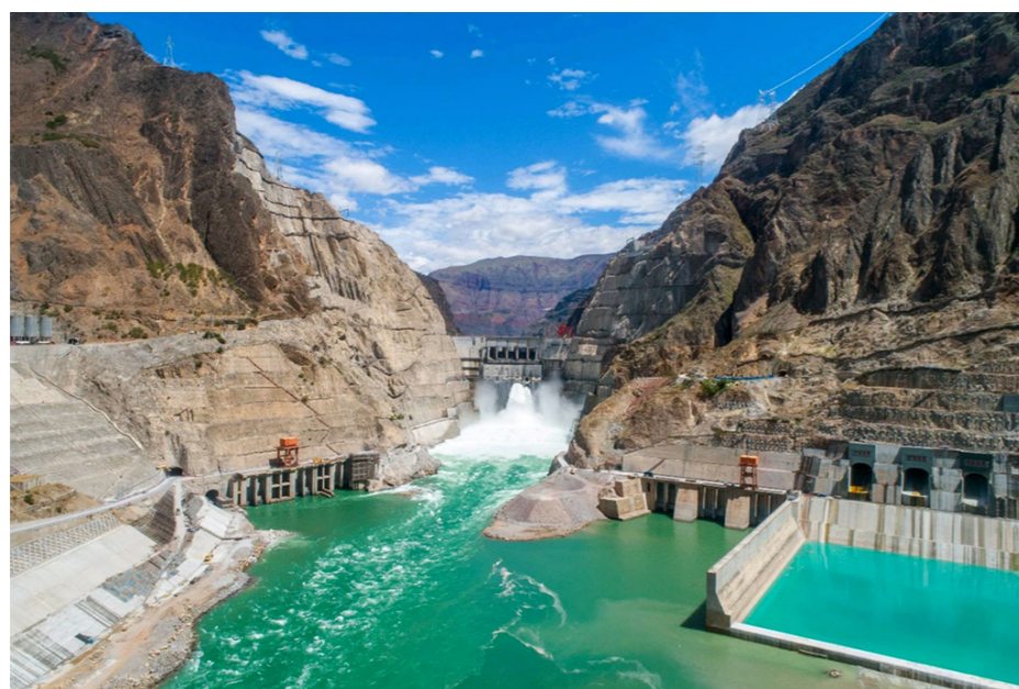
三峡乌东德水电站
