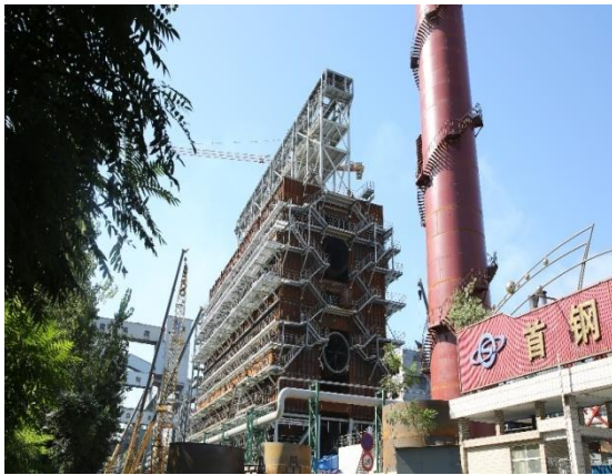
迁钢公司球团二系列脱硫脱硝系统
