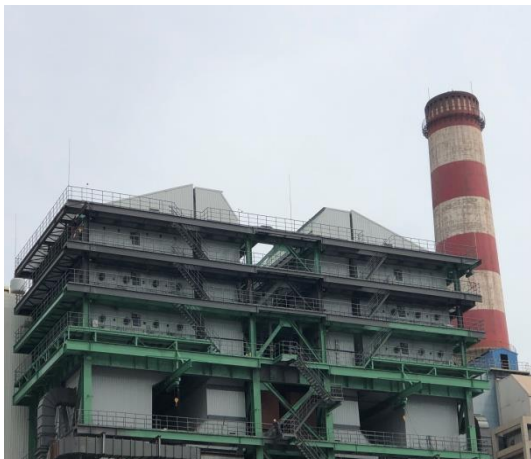
京唐公司烧结烟气脱硫脱硝
