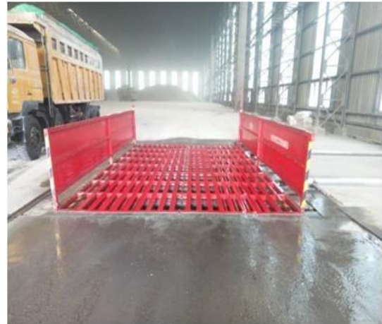
京唐公司供料部灰石料场洗车台
