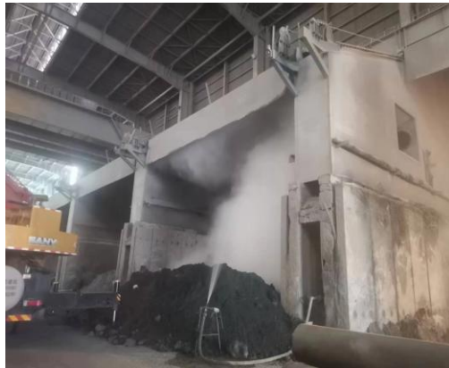
京唐公司钢轧泼渣池除尘罩改造
