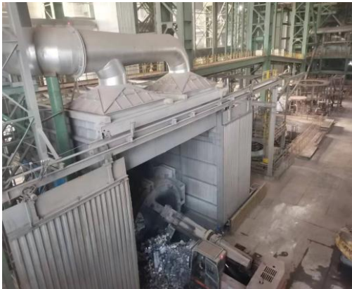
京唐公司连铸5#倾翻除尘罩改造
