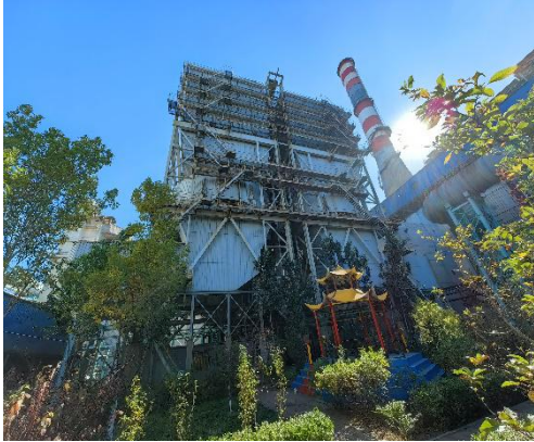
迁钢公司三烧脱硝提升项目
